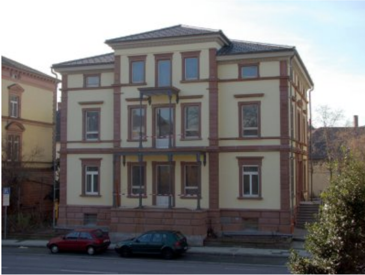
Leerstehendes Haus im Werderding 14
