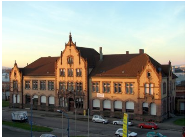
Leerstehender Güterbahnhof in der Neunlindenstraße
